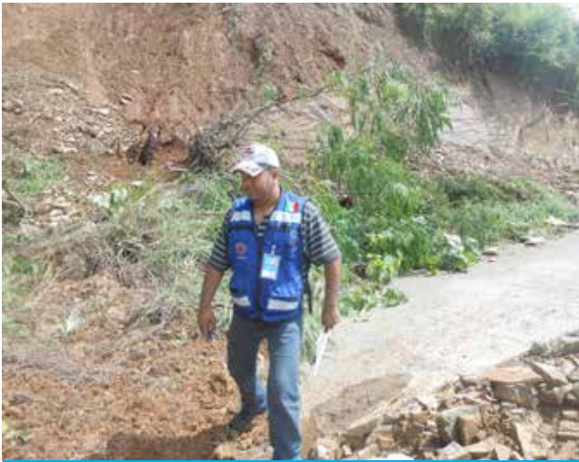
Verificación de derrumbe
