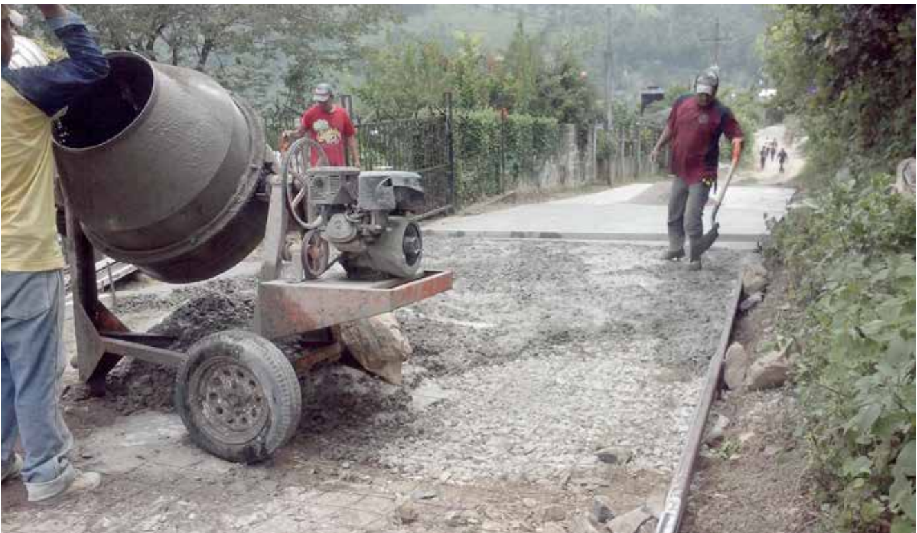
Pavimentación en la Comunidad de Puerto de Potrerillos
