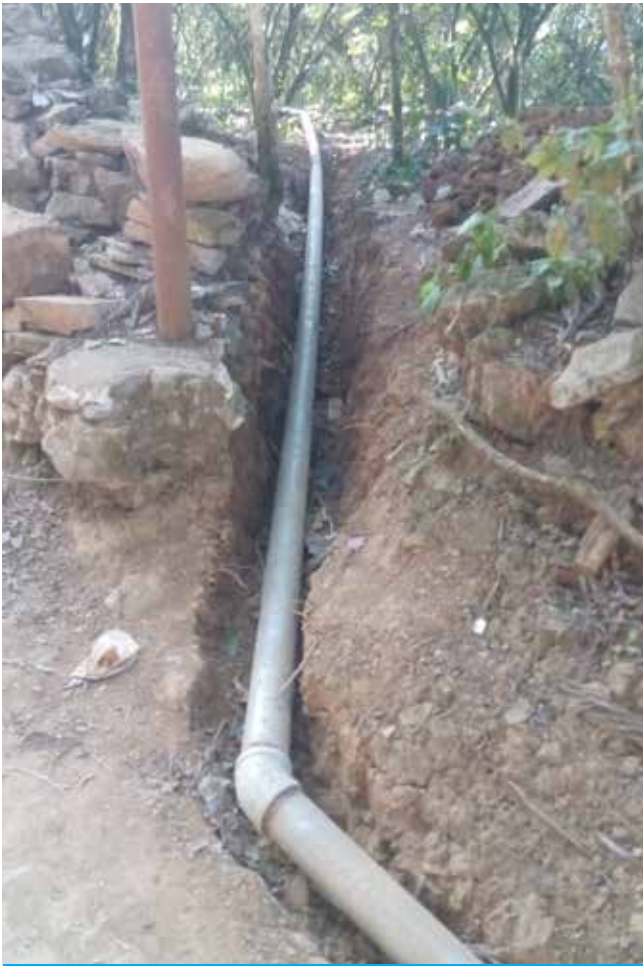
Reparación de Drenaje en La Pagua
