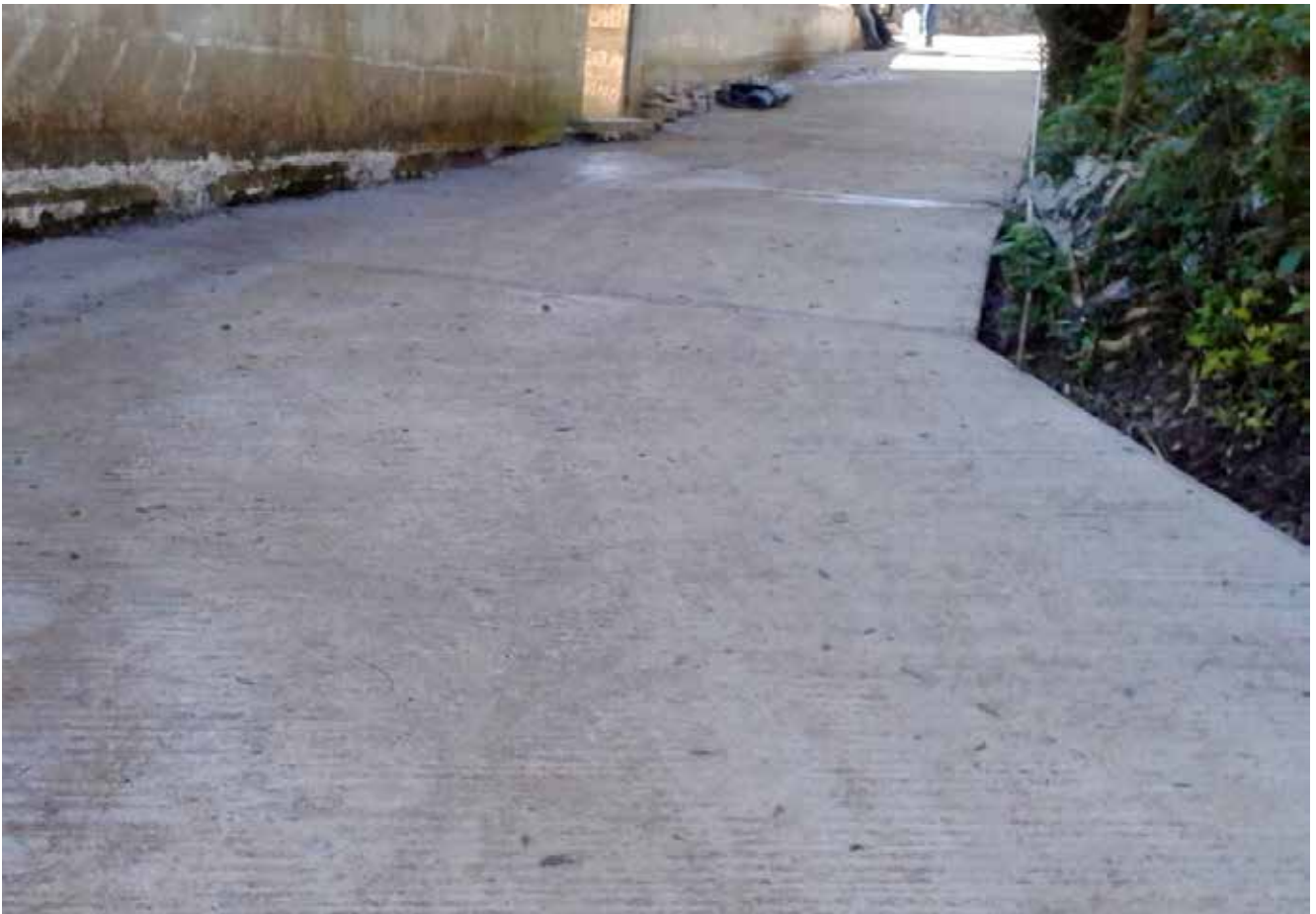
Pavimentación de calle en El Sabino
