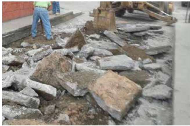
Pavimentación de calle Escontria
