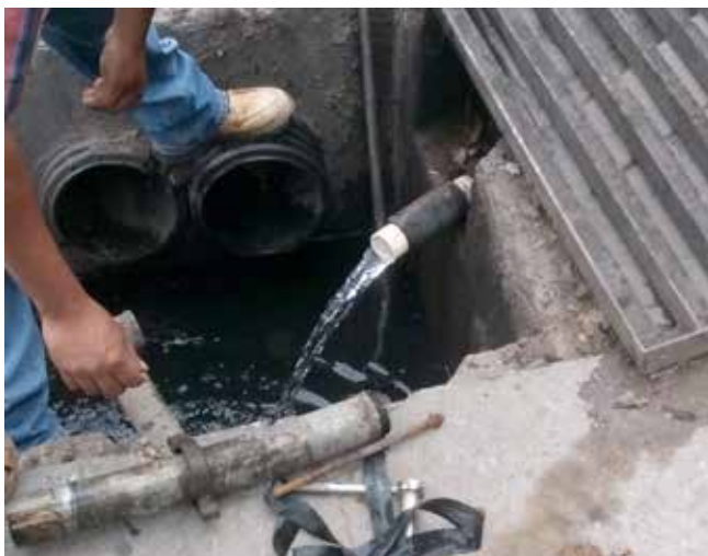
Desasolve de drenaje en calle Santa Mónica
