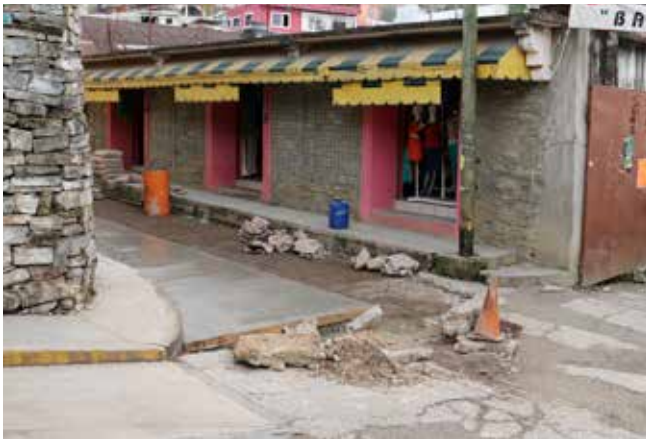
Pavimentación de calle Escontria
