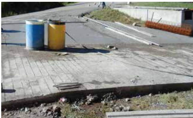
Pavimentación en la Comunidad de Puerto de Potrerillos
