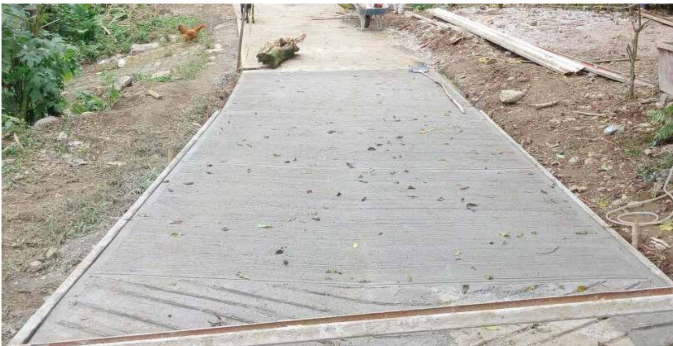
Pavimentación en la comunidad de Huaxuco Xilitla
