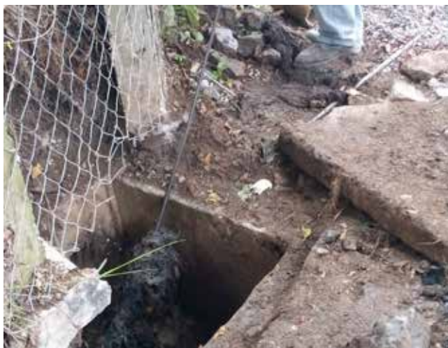
Desasolve de drenaje en la calle Adolfo López Mateos
