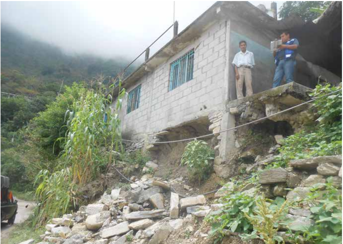
Verificación de Casa
