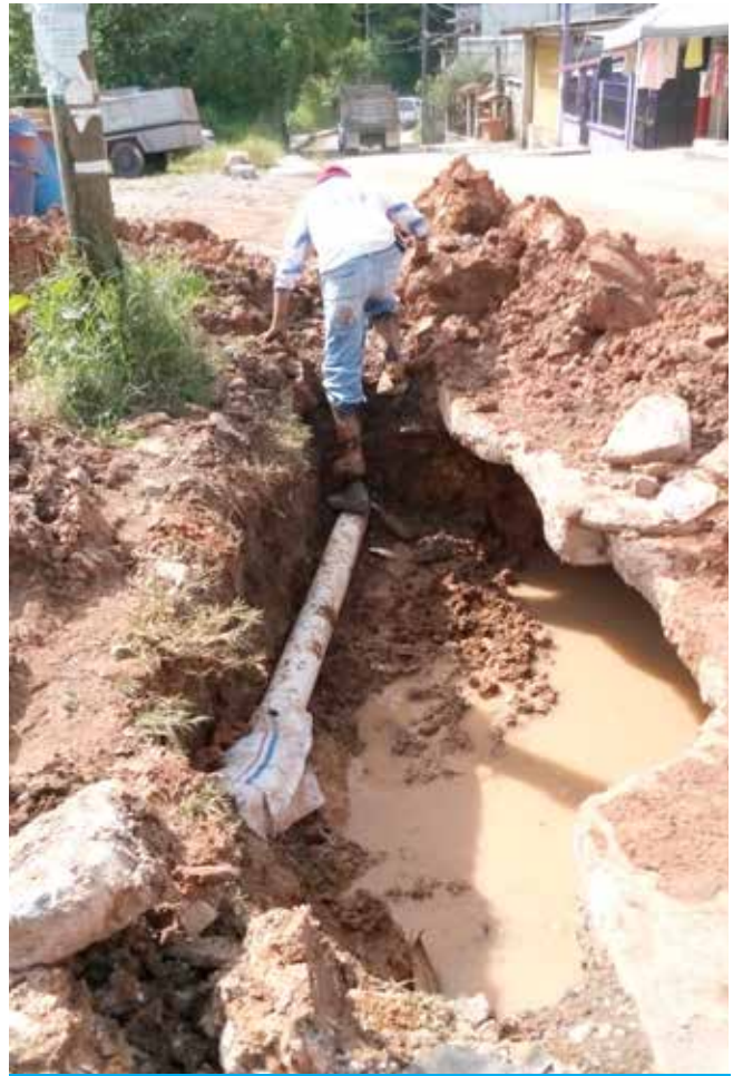
Reparación de fuga de drenaje en la calle Morelos
