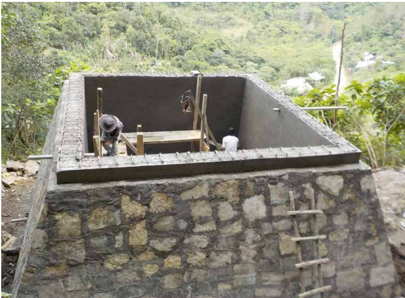
Construcción de Deposito Agua De Cuayo
